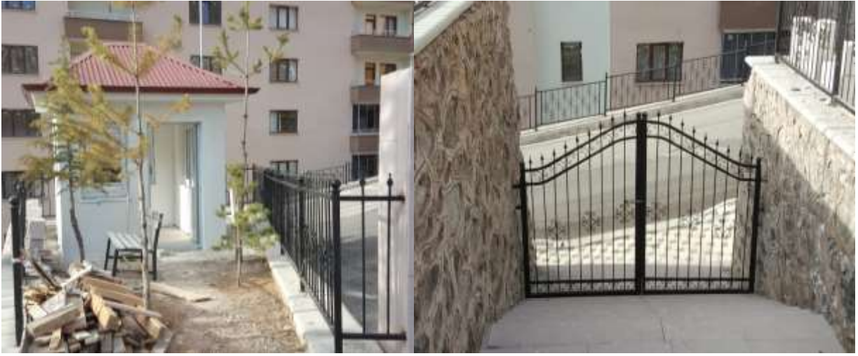
Merkez M. Ç. Sosyal Bilimler Lisesi Bekçi Kulübesi ve Demir Kapı Yapım İşi
