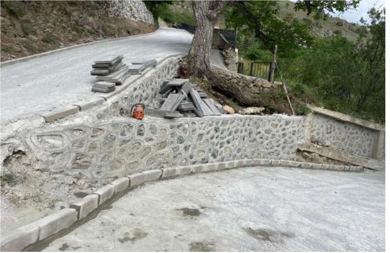
Şehit Öğretmen Necmettin Yılmaz Mezarlığı Yol Yapımı
